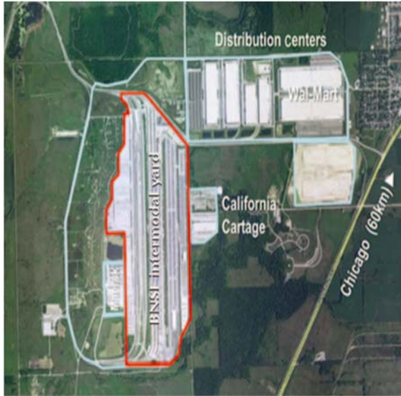
Figure 7. Centerpoint Intermodal Center (Luis C. Blancas, 2014)
